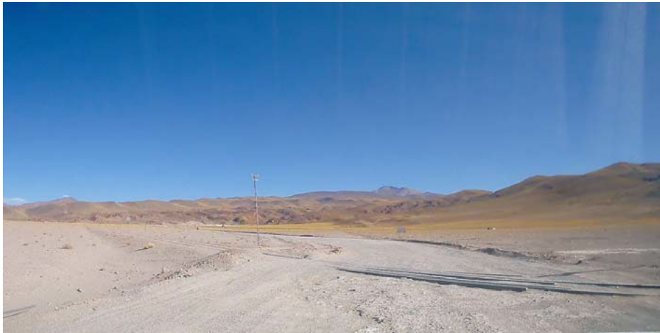
Ilustración 9- RN 51, cruce del ferrocarril C 14
