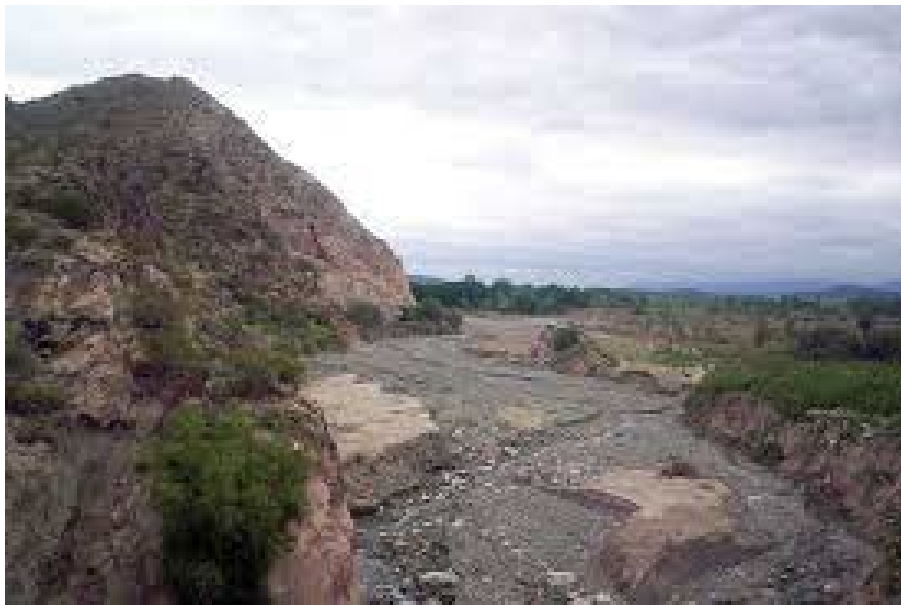
Ilustración 11- RN 153, sector de huella de difícil transitabilidad
