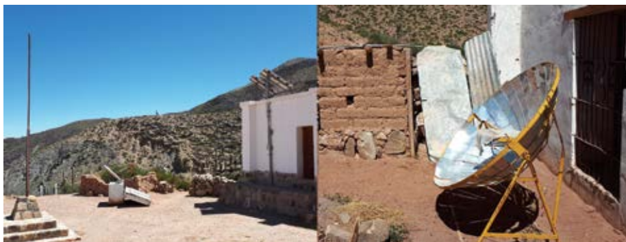
Escuela 352, Alfarcito, Jujuy. Paneles fotovoltaicos, horno solar y cocina solar de concentración de la radiación por medio de espejos parabólicos (Jujuy, 2019).
