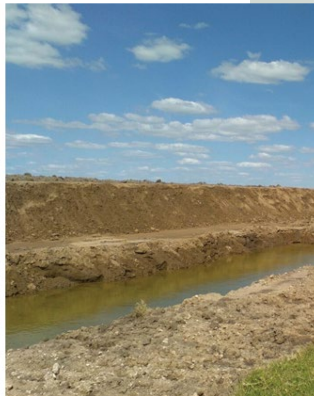
Inicio de las tareas de excavación
