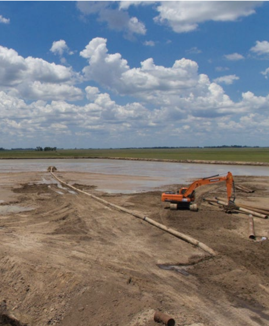
Relleno de terrenos
