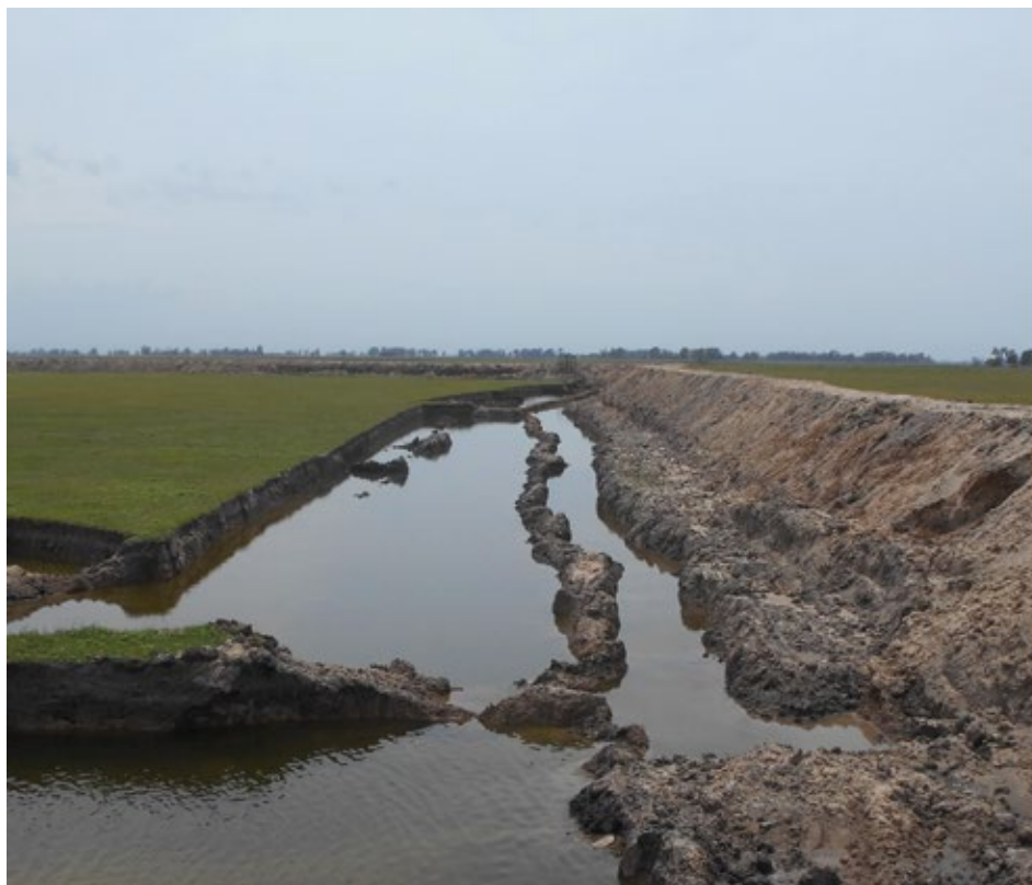
Inicio de las tareas de excavación
