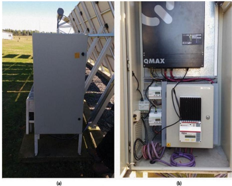
**Figura 5.** (a) Armario de contención para inversor y regulador de carga. (b) En la parte superior se encuentra el inversor de 3000 W y en la parte inferior, el regulador de carga.
