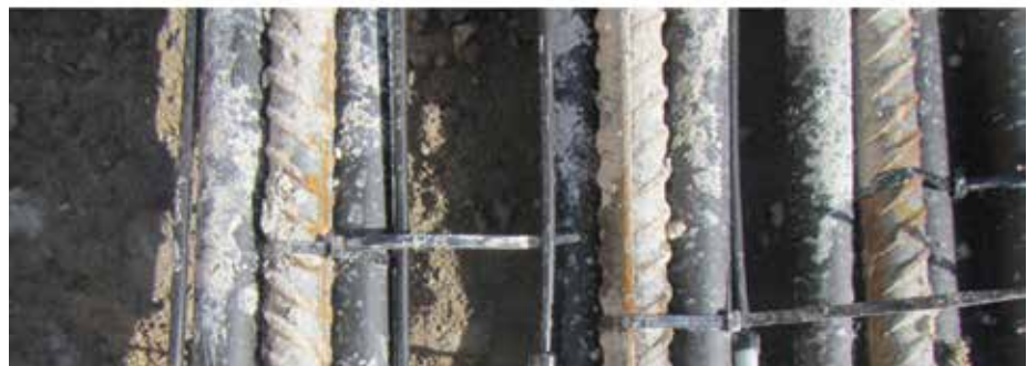
Columnas de cimentación con sondas geotérmicas embutidas.
