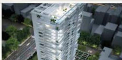
OBRA: TORRE ASTOR - C.A.B.A - 30.677m 2
