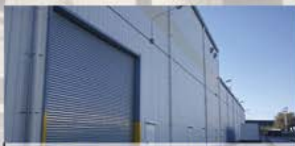
AMPLIACIÓN PLANTA FIRMENICH DON TORCUATO - TIGRE - 3.665m 2
