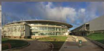
OBRA: Y-TEC-CONSTRUCCIÓN DE SEDE YPF-TECNOLOGÍA BSAs - BERISSO - 13.322m 2
