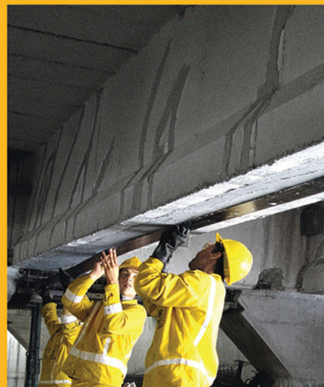
REPARACIONES Y REFUERZO
