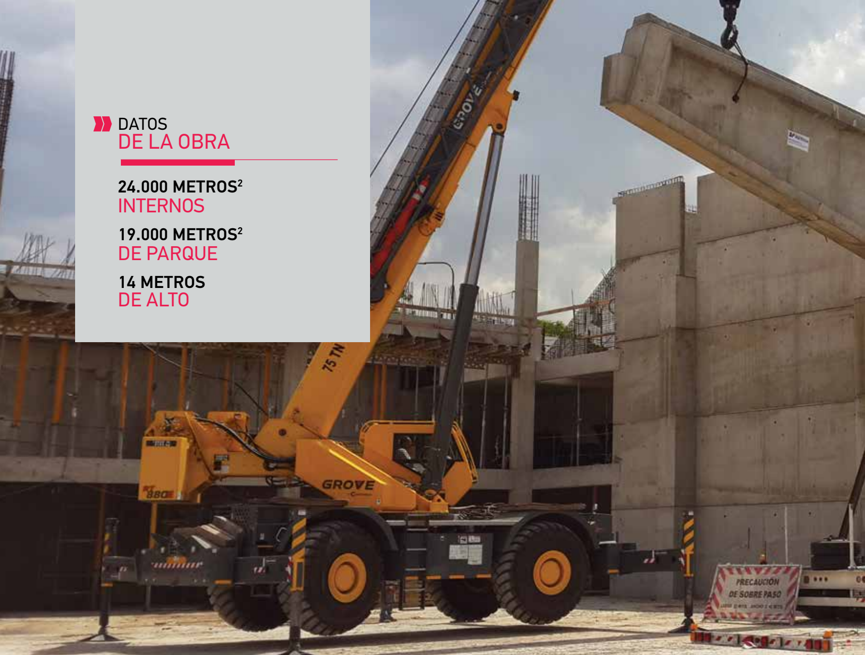
El momento del izaje, con la fuerza y sincronización de 2 grúas.
