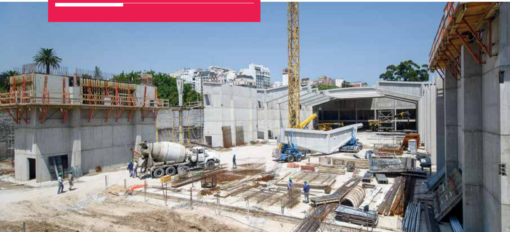
Llegada de los camiones especiales con carretones. En el centro, una de las piezas premoldeadas formando lo que sería una especie de acoplado.
