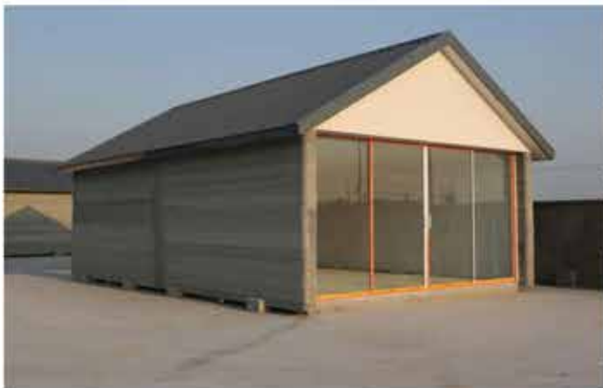
Viviendas construidas por la empresa Winsun en 24 horas
