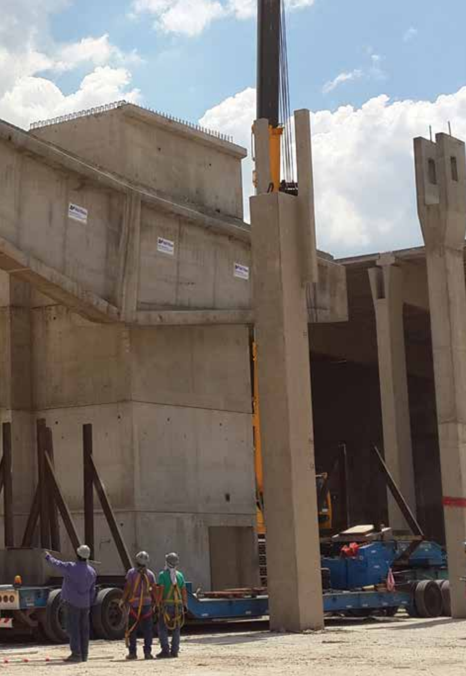
La sala plenaria y sus "gaviotas" –así llaman en la intimidad de la obra a las piezas premoldeadas por su similitud con las alas-, con una luz imponente de piso a cielo raso.
