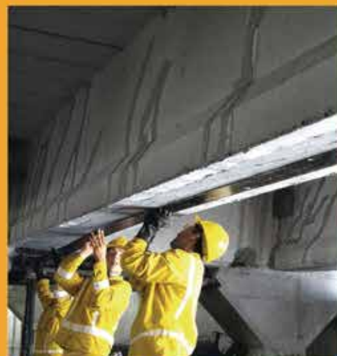
REPARACIONES Y REFUERZO
