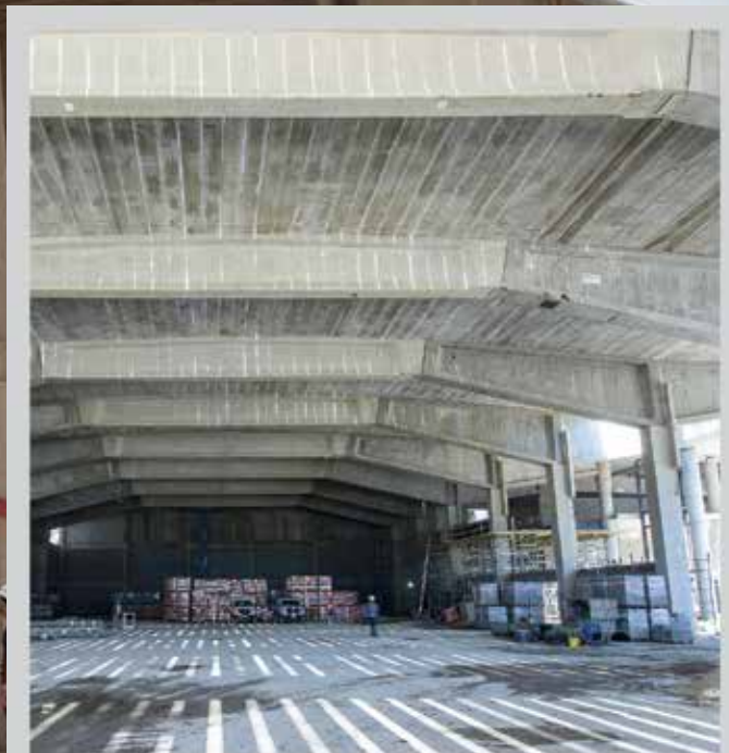
La sala plenaria y sus "gaviotas" –así llaman en la intimidad de la obra a las piezas premoldeadas por su similitud con las alas-, con una luz imponente de piso a cielo raso.
