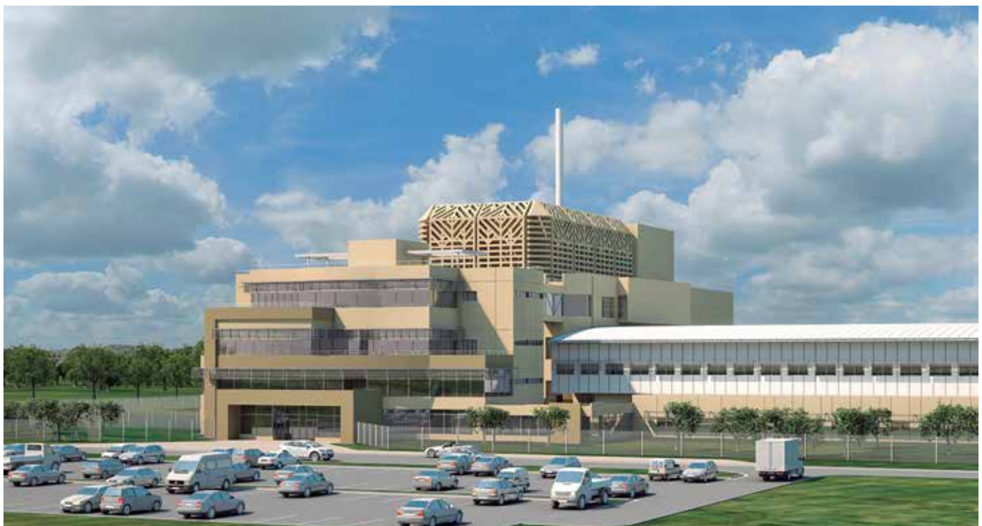
RA-10 Obra Civil
