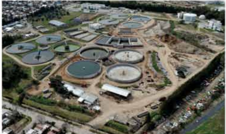
CONSTRUCCIÓN DE PLANTA DEPURADORA NORTE . TRATAMIENTO DE LÍQUIDOS CLOACALES
