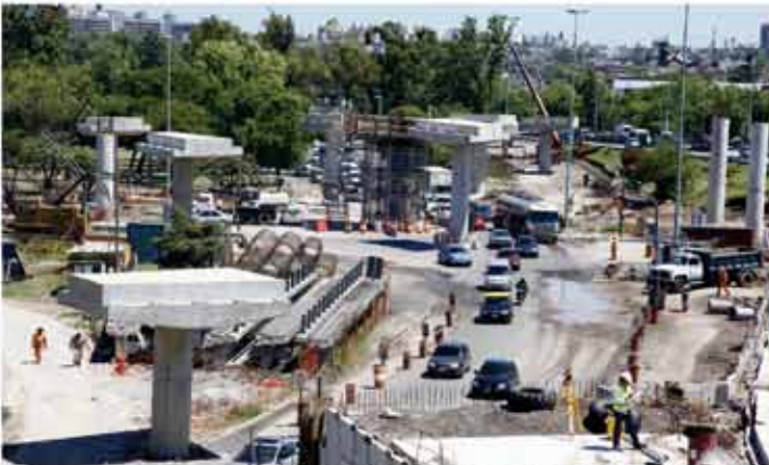
CONSTRUCCIÓN DEL DISTRIBUIDOR DELLEPIANE. BUENOS AIRES
