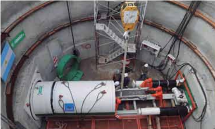
CONSTRUCCIÓN DE COLECTOR TIGRE
