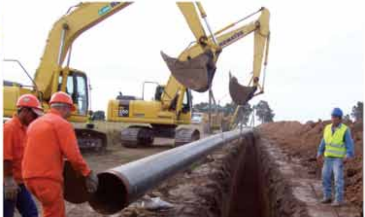
CONSTRUCCIÓN DE GASODUCTO. URUGUAY
