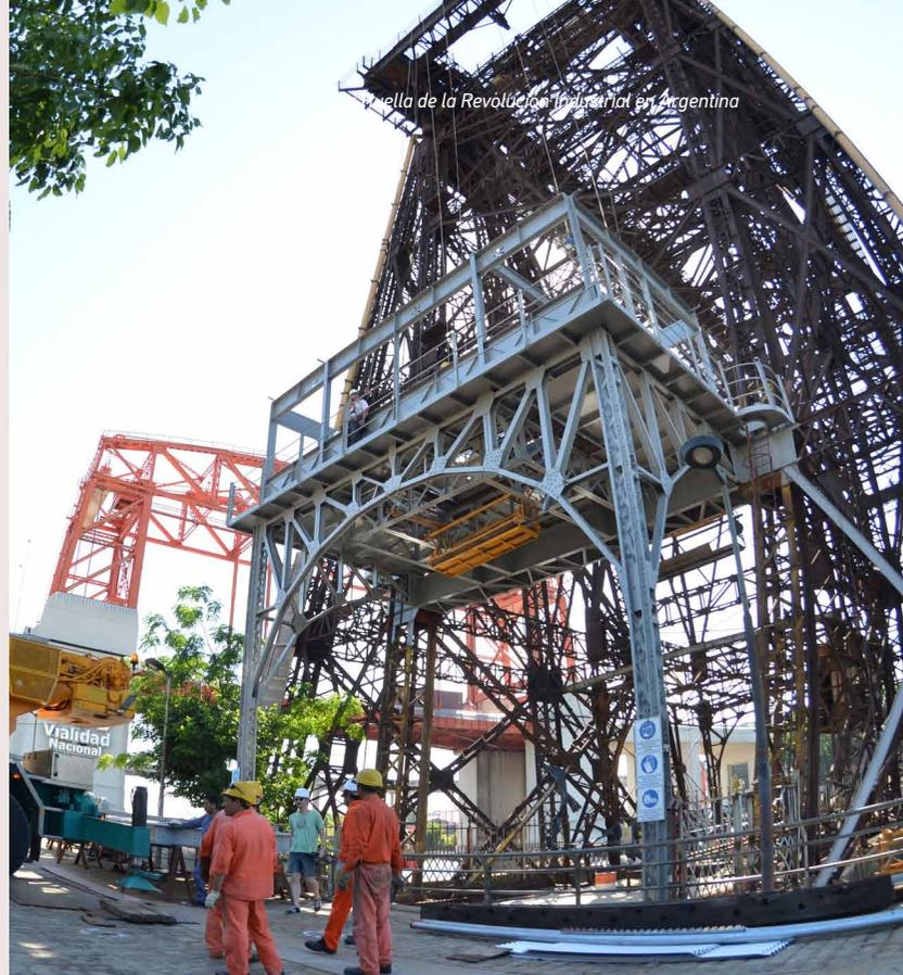
Sobre las torres laterales se sostiene una viga superior de la cual pende la barquilla, denominada plataforma transbordadora, de 8 metros de ancho por 12 de largo y capacidad para soportar hasta 50 toneladas de peso. En la barquilla se transportaban peatones, carros y tranvías, con una capacidad máxima de 30 personas y 4 vehículos. El recorrido entre una y otra orilla duraba cinco minutos.
