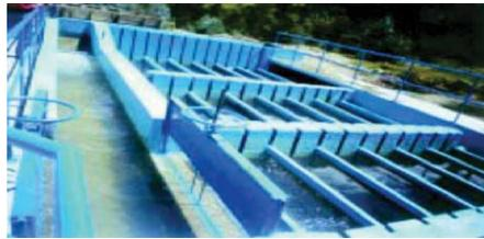
Figura 1. Floculadores hidráulicos de flujo vertical.
