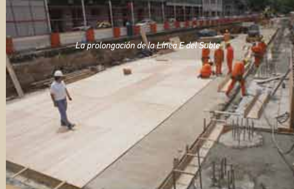
Foto 1 y 2: Ejecución de la losa superior este de la estación Correo Central, sobre Av. Leandro N. Alem.
