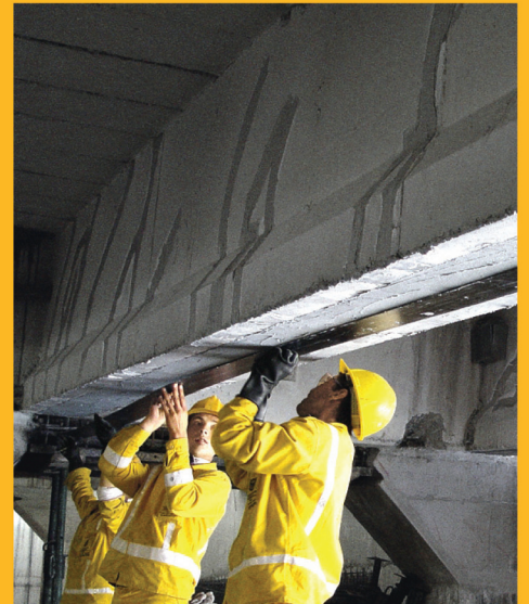
REPARACIONES Y REFUERZO
