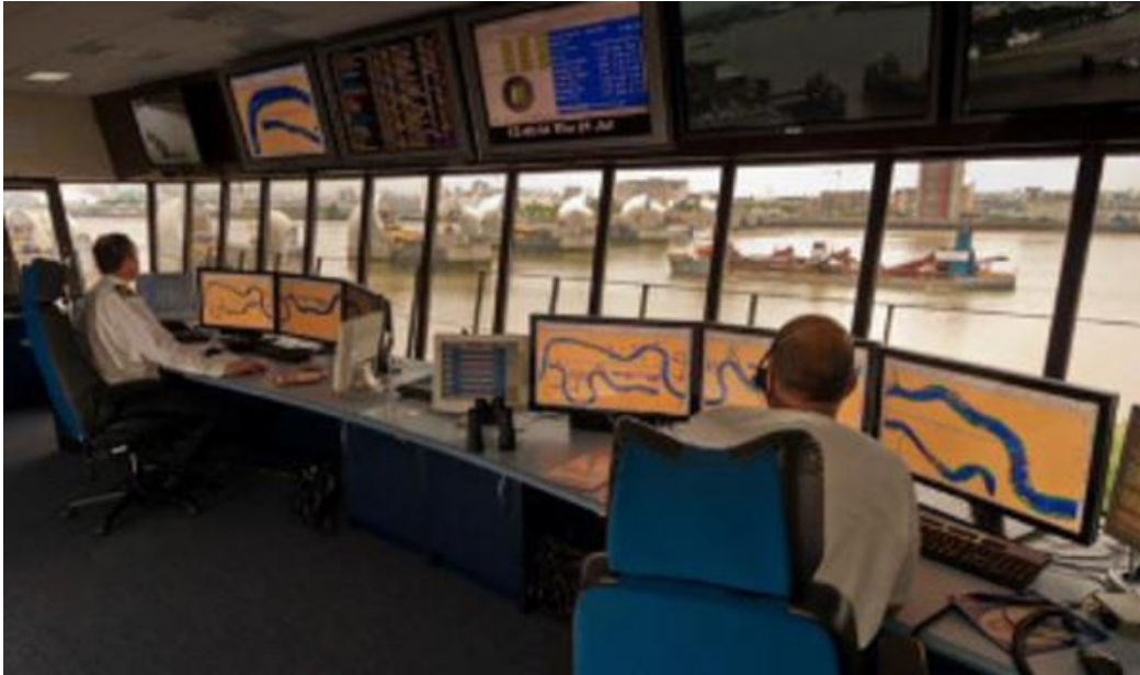
Figura 28: Centro de control de un RIS
