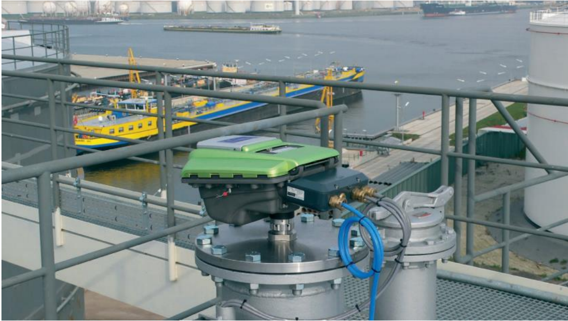
Figura 14: Radar Honeywell Enraf Flexline para medición de niveles y volúmenes en tanques de combustibles
