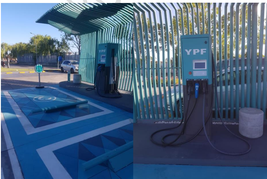
Figura 18: Imágenes de una estación de carga de baterías de auto eléctrico.
